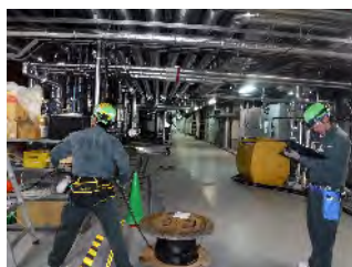
メーカー工場内電気工事の様子
